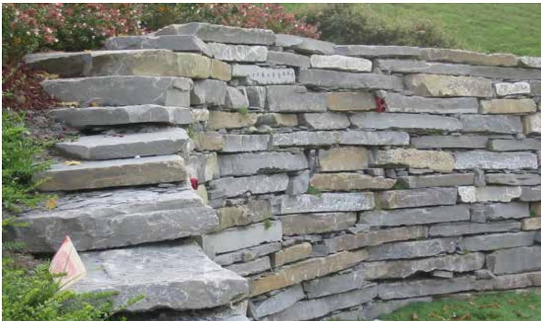
*Un muro a secco che abbiamo realizzato per il contenimento di un'intera scarpata che sovrasta una piscina*
