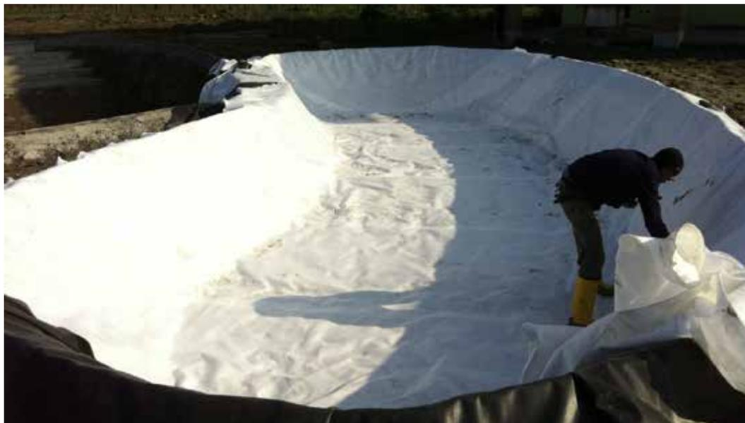
*Posa e relativa saldatura a caldo del geotessuto di protezione*
