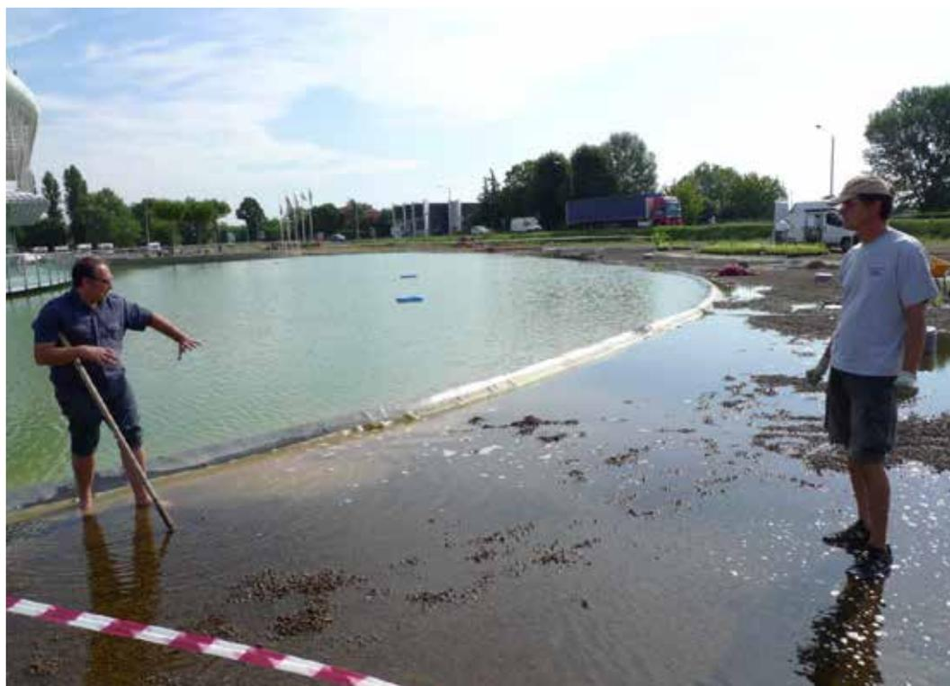
*La preparazione per la piantumazione delle piante in fitodepurazione sul letto di lapillo vulcanico.*
