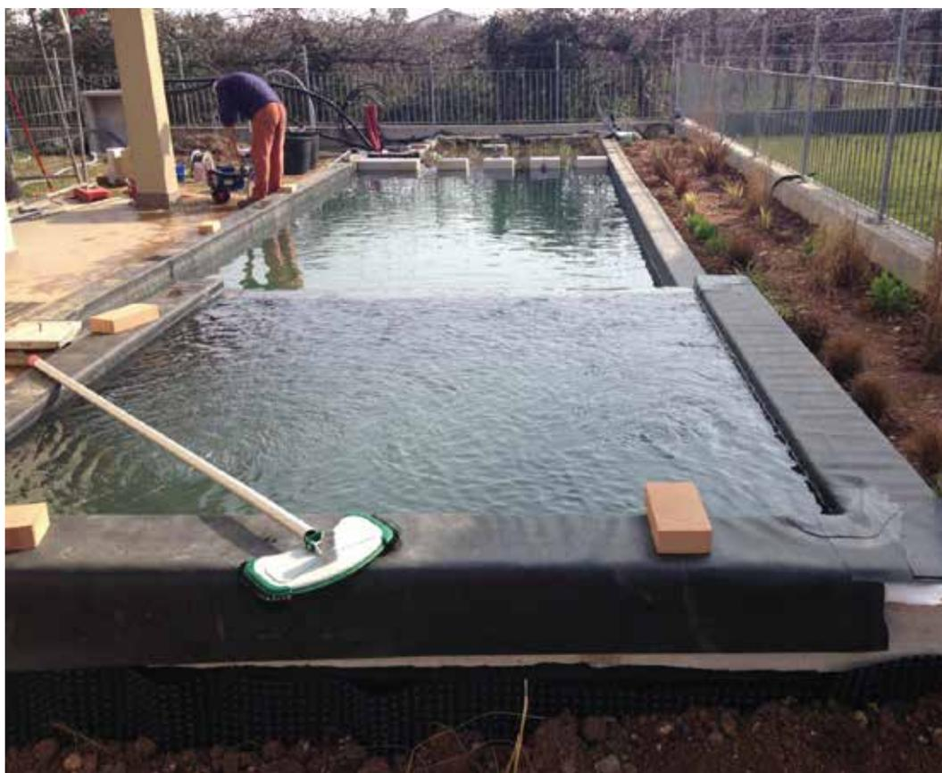
*Un nostro biolago formale in fase di ultimazione. In primo piano troviamo la vasca dei bambini, caratterizzata da una profondità di cinquanta centimetri. Al centro la vasca balneabile di centoquaranta centimetri ed in fondo il bacino di fitodepurazione.*
