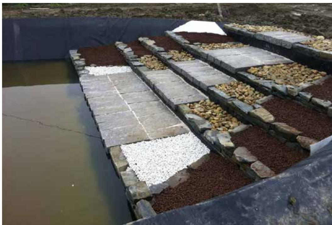
*Ultimi lavori di formazione di un ingresso a scale nel biolago di un nostro cliente. Lateralmente abbiamo creato apposite aiuole che ospiteranno le piante sommerse. In alto nella foto si nota ancora un lembo di geotessuto di protezione, ancora da rifilare.*
