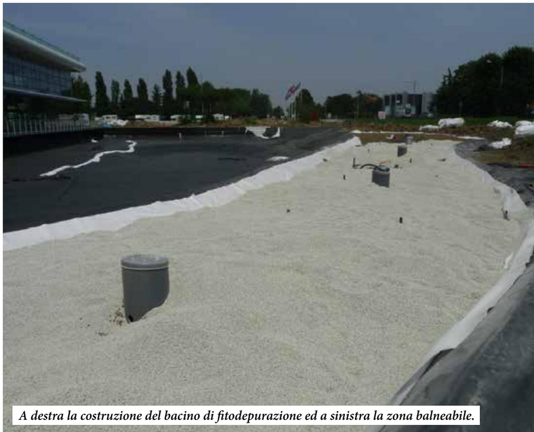
La zona di balneazione è solitamente libera da tutto mentre quella di fitodepurazione è saturata di inerte che diventa il substrato ideale per le piante palustri e la dimora perfetta per la micro e macro
