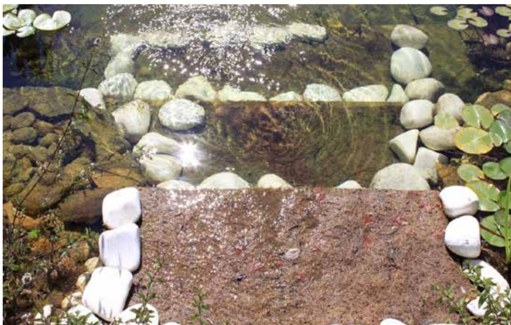
*In questo caso, abbiamo rivestito le scale d'ingresso con una stuoia in fibra di cocco per evitare spiacevoli scivolate. La lenta ma continua biodegradazione del cocco può colorare leggermente l'acqua di marrone.*
